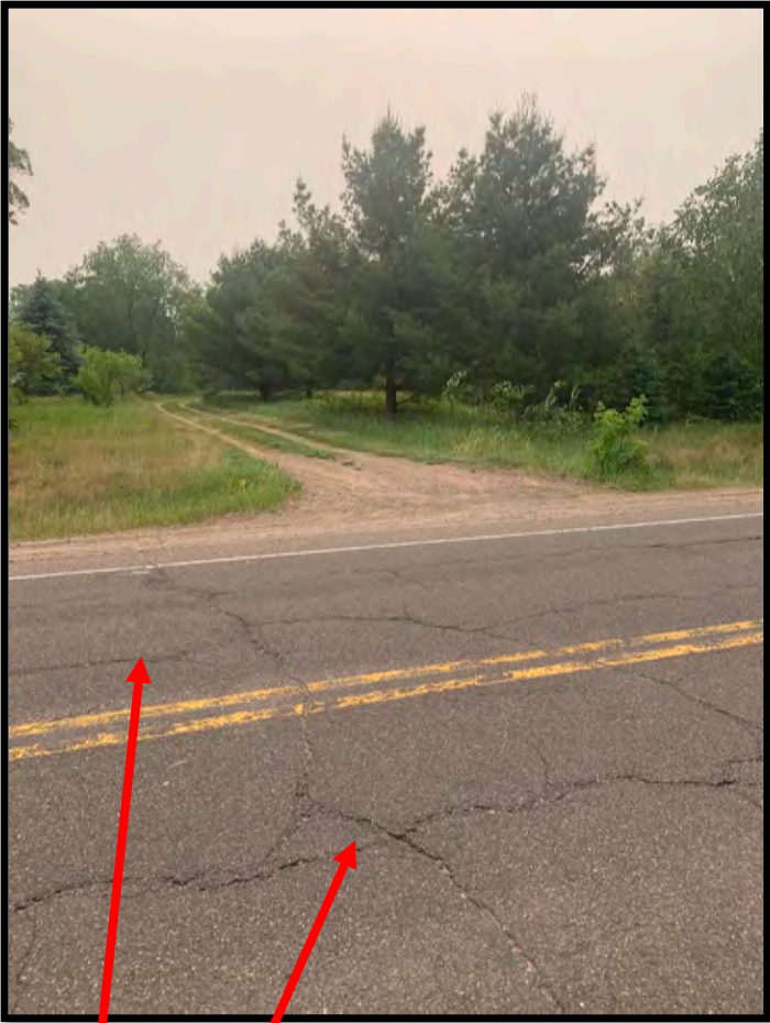
Longitudinal cracking
